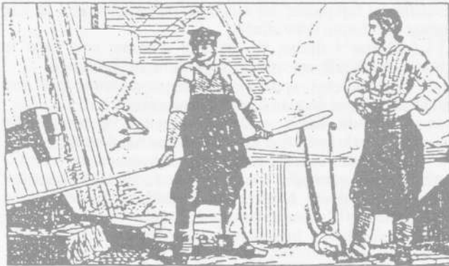
La fabrication du petit fer au martinet.
